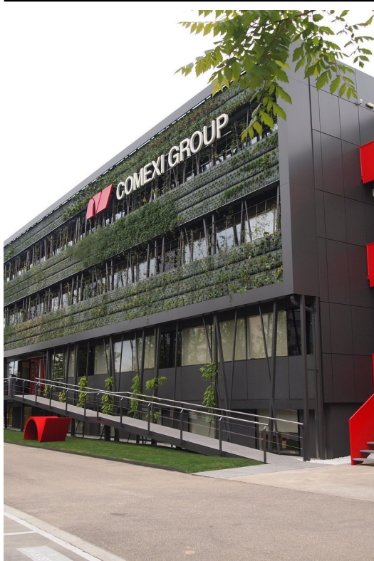
Façana de l'empresa Comexi Group, al polígon de Riudellots. Foto: EL PUNT AVUI.
