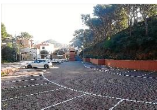
Imatge de la part superior de l'aparcament soterrat de sa Tuna.
