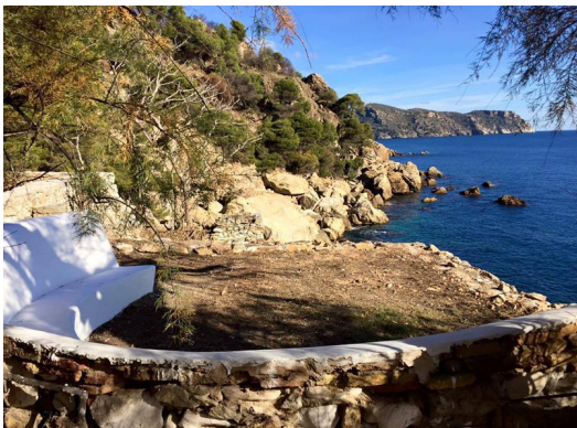
Un dels espais que s'estant recuperant com a mirador al llarg del camí de ronda de Roses amb les obres actualment en curs Foto: EL PUNT AVUI.
