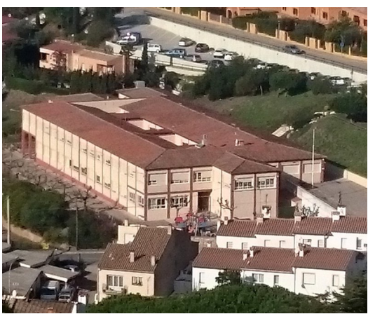
Imatge aèria de l'escola pública Doctor Arruga de Begur, que allotjarà l'aula de l'esplai. Foto: EL PUNT AVUI.
