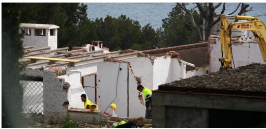
Una imatge dels primers treballs d'enderroc de les parts més antigues del Bulli, al mes de març del 2015 Foto: MANEL LLADÓ.
