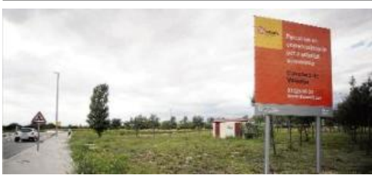
Els terrenys de la zona industrial urbanitzats i aturats des de fa anys.
