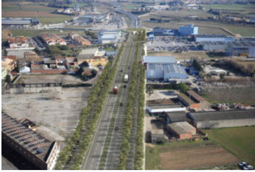
Imatge del traçat de la carretera
