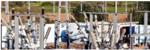
Arrenca el desmantellament de la subestació elèctrica de Forallac
