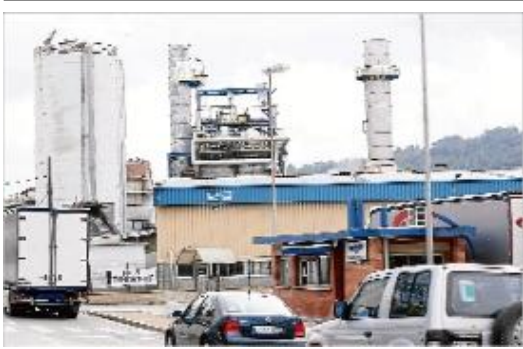
La planta de Torrapapel que l'any passat va comprar Hinojosa.
