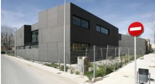
Les dues façanes que el TSJC va determinar que estaven en situació irregular · Aniol Resclosa
