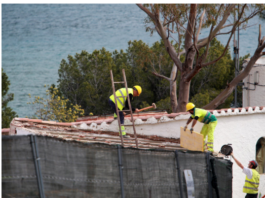
Les obres que s'estan fent al Bulli, a la Cala Montjoi de Roses. Foto: MANEL LLADÓ.
