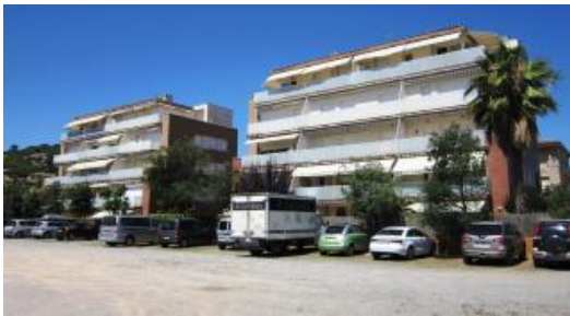
Calonge haurà de pagar 332.271 per no enderrocar els edificis Llevantí
