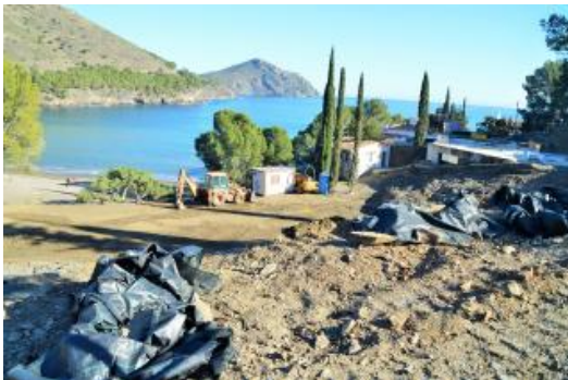
Estat actual de les obres.
