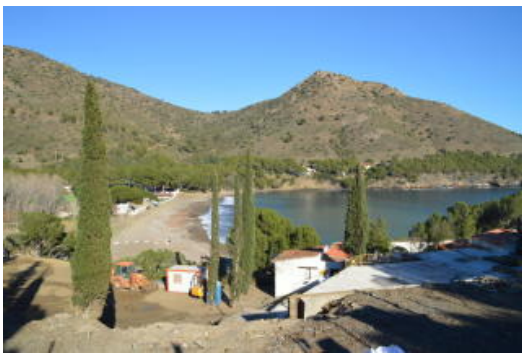
El Bulli en obres
