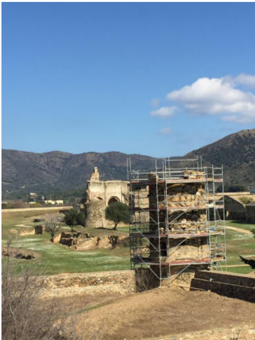
Les obres ja s'han iniciat.
