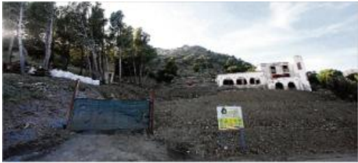
Les obres que s'estan portant a terme per ampliar El Bulli.
