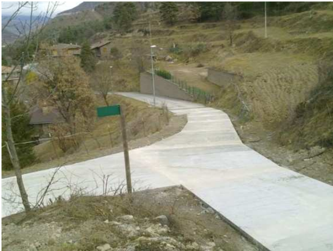
Pavimentació del barri del Castell
