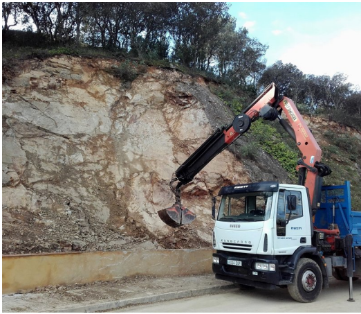
Treballs de consolidaci del tal s. Foto: EL PUNT AVUI.
