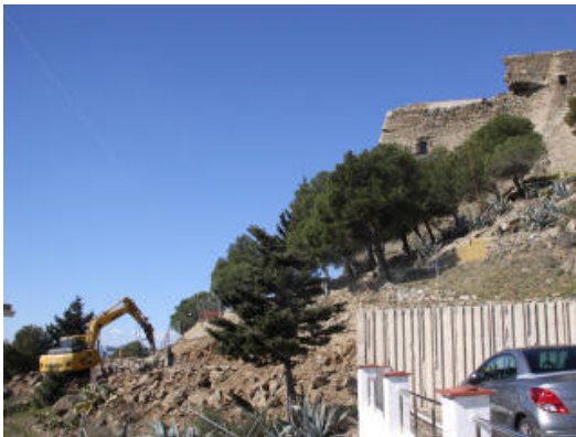
Les obres del nou pàrquing ja s'han iniciat.
