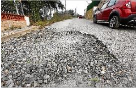
L'asfaltatge en un dels carrers pendents d'urbanitzar a Mas Tomasí.
