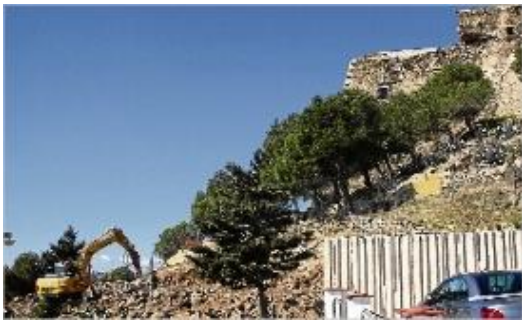
Les obres de construcció de l'aparcament.
