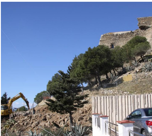
El nou aparcament facilitarà l'accés a la part alta del Castell de la Trinitat Foto: EPA.
