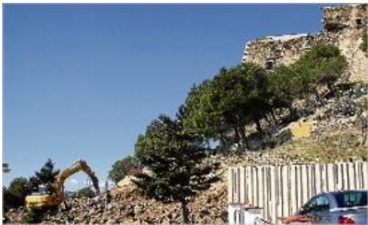
Les obres de construcció de l'aparcament.
