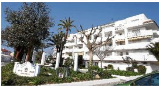
L'edifici del Royal Marine II, del qual s'havia d'enderrocar l'última planta per poder rebaixar els 1,13 metres.
