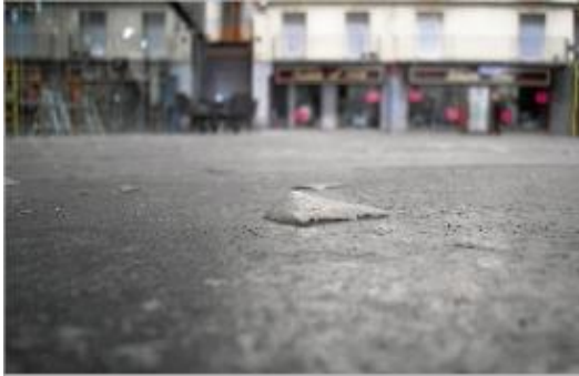
El terra de la plaça coberta de La Lira.
