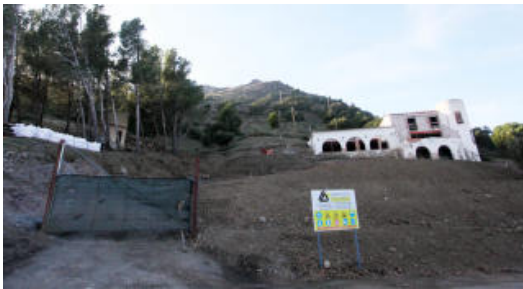
Roses atura les obres a l'exterior d'El Bulli perquè es fan sense permís
