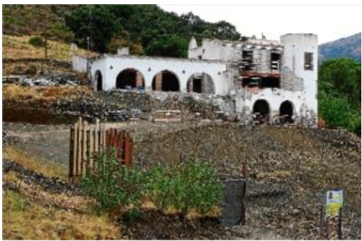
Les obres que s'han portat a terme a l'exterior de l'habitatge de Ferran Adrià.
