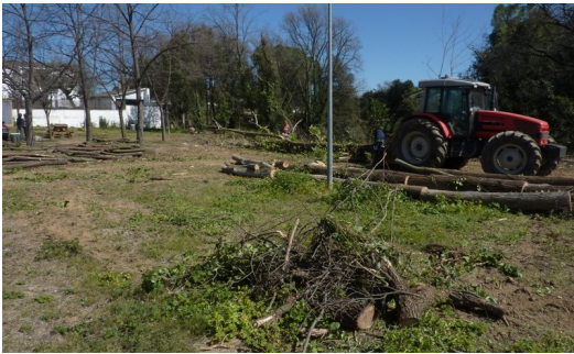
Treballadors forestals apilant els troncs que retiren del clot, la setmana passada. Foto: R. E.
