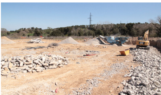
Els treballs de desmantellament de la subestació, en una fase molt avançada. Foto: E.A.
