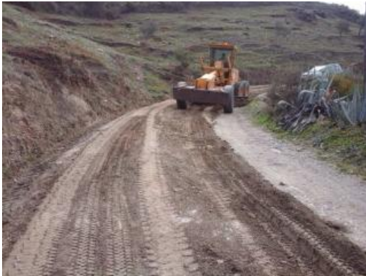
Les obres de millora del camí de Jòncols.
