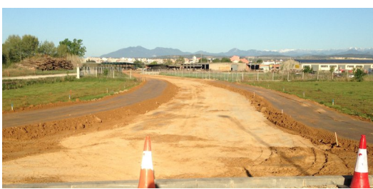
El vial sud de Vilatenim està progressant i les cotes ja s'igualen. Foto: JOAN PUNTÍ.
