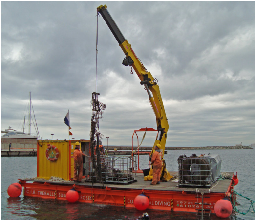
Imatge dels treballs de neteja. Foto: PORTS.
