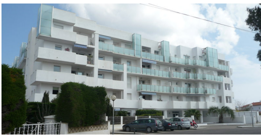
L'edifici del Royal Marine II estava pendent d'una sentència d'enderroc que finalment no s'excutarà
