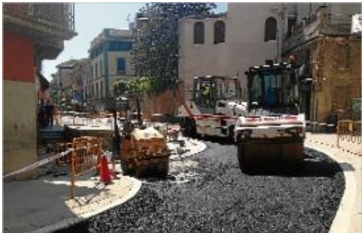
L'asfaltatge es farà als carrers Camprodon i Pont.
