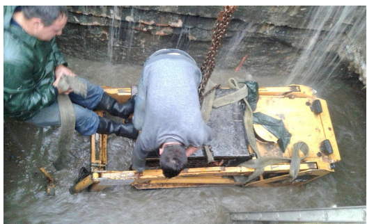
Operaris durant els treballs de neteja, accedint al torrent des d'un registre Foto: EPA.
