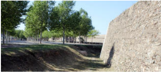
El rec, després d'una neteja i desbrossament, en un tram que voreja la Ciutadella.
