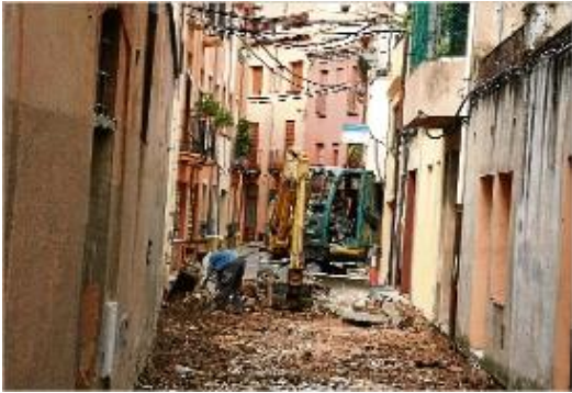
Reforma del carrer dels Valls de Banyoles
