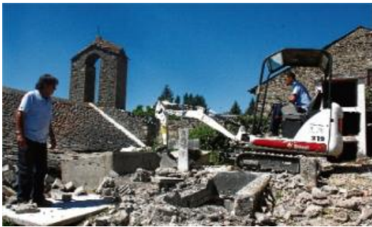
Dos operaris treballant en la retirada de restes de l'antic cementiri amb una petita excavadora.
