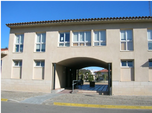
L'exterior de la biblioteca palsenca, que es reformarà al llarg d'aquest estiu Foto: EL PUNT AVUI.
