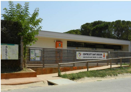
Façana del centre BTT de Sant Gregori. Foto: EL PUNT AVUI.
