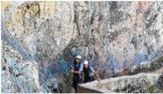
Operaris treballant en la col·locació de tanca metàl·lica.
