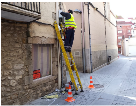
Un operari treballant a Palamós, on ja ha arribat Foto: J.T.
