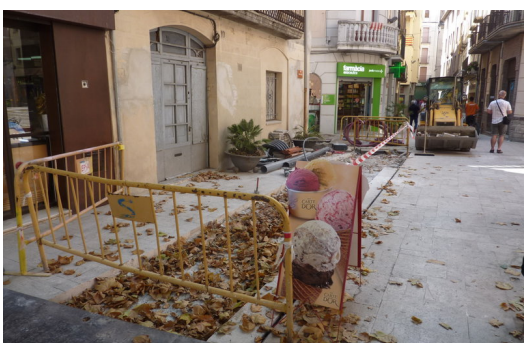
Les obres a la plaça, la setmana passada. Foto: R. E.
