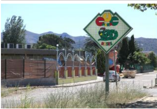
Les obres de renovació del parc estan en marxa.
