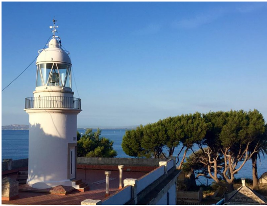
El far de Roses i part dels exteriors, més arran de mar, on s'ha excavat la bateria Foto: EPA.
