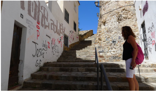
Les parets de la pujada a l'església de Santa Maria i la regidora Pepa Celaya. Foto: N. FORNS.
