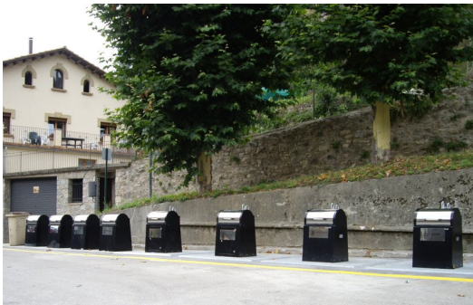
Una bateria de contenidors soterrats en un carrer de Camprodon. Foto: EPA.
