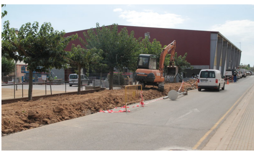
Les obres a l'entorn del pavelló poliesportiu de Mont-ras Foto: E.A.
