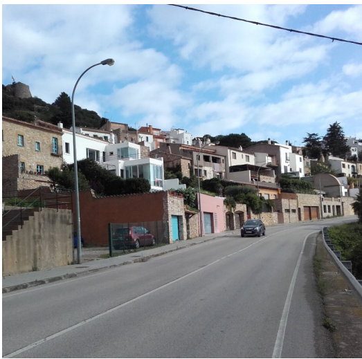
El vial de Circumval·lació de Begur, on els treballs habilitaran un carril segregat per a bicicletes i vianants Foto: E.A.
