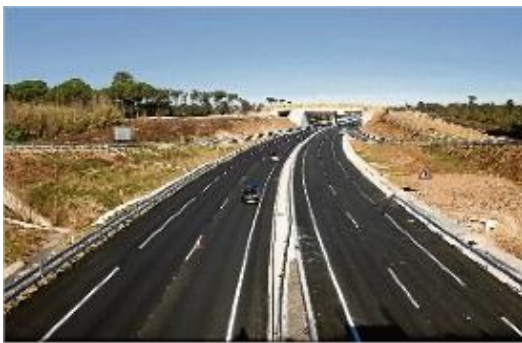
El tram de l'autovia A-2 entre Sils i Fornells de la Selva.
