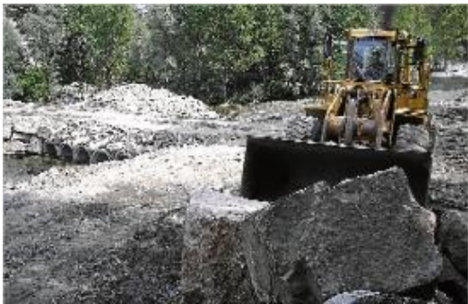
Les obres, a la confluència dels dos rius.
